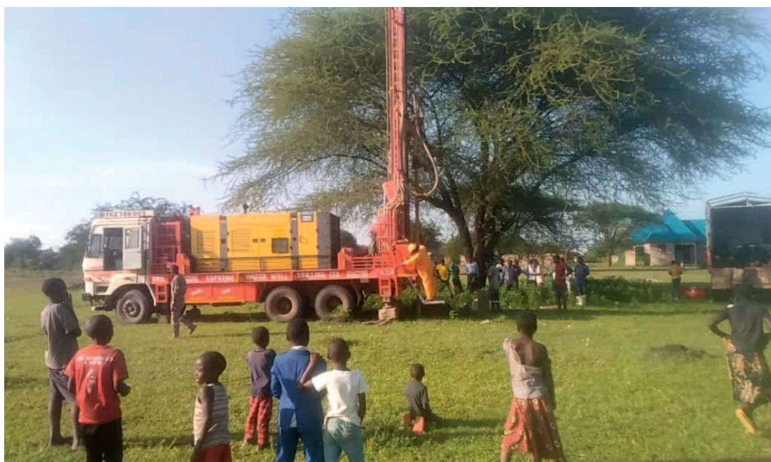
Un evento tanto atteso per tutto il villaggio di Chingurubila: lo scavo del pozzo!
