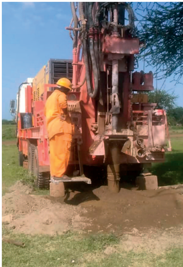
I lavori dello scavo a Chingurubila, Tanzania
